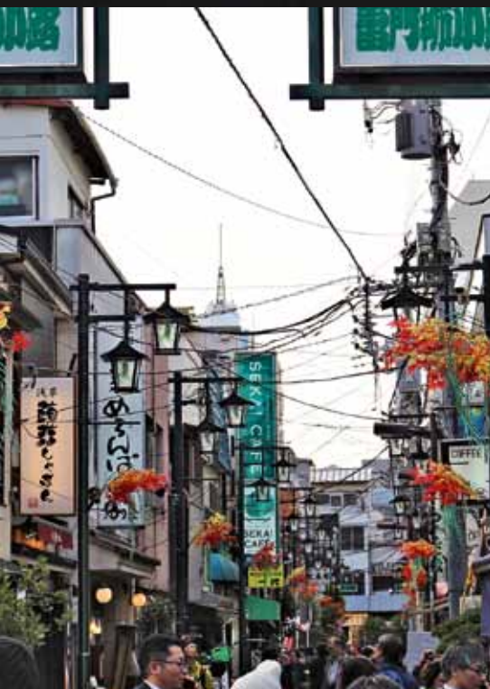
Elektrické dráty a kabely jsou v Japonsku vedeny „horem“. V případě poškození v důsledku zemětřesení jsou tak mnohem snadněji opravitelné
